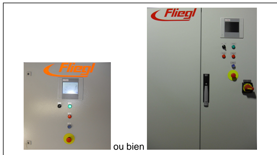
Fig. 3: Postes de travail sur la machine
