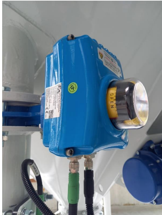
Das Absperreklappe ist komplett geöffnet („open“ – gelb)
