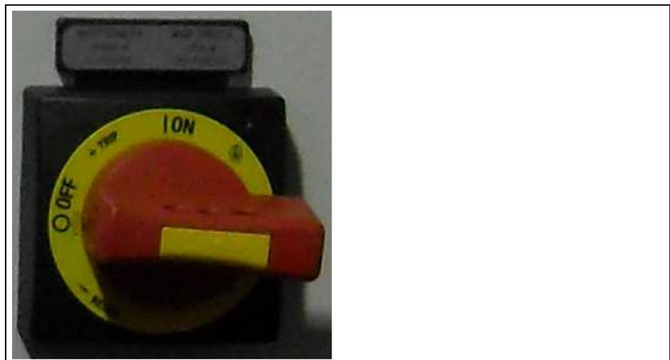
Figura 7: Apparecchiatura di rete e dispositivo di esclusione
