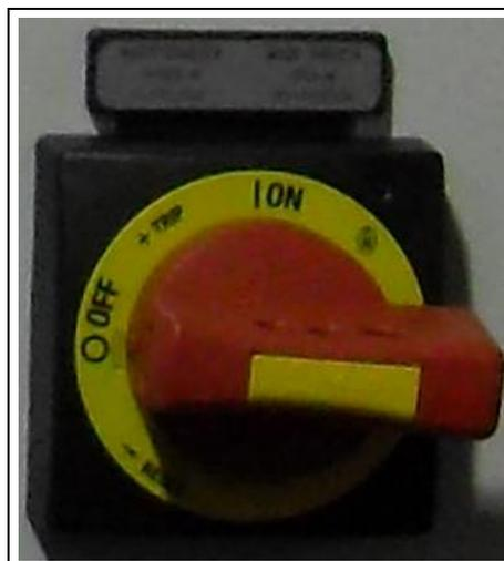
Abbildung 7: Netz-Trenneinrichtung
